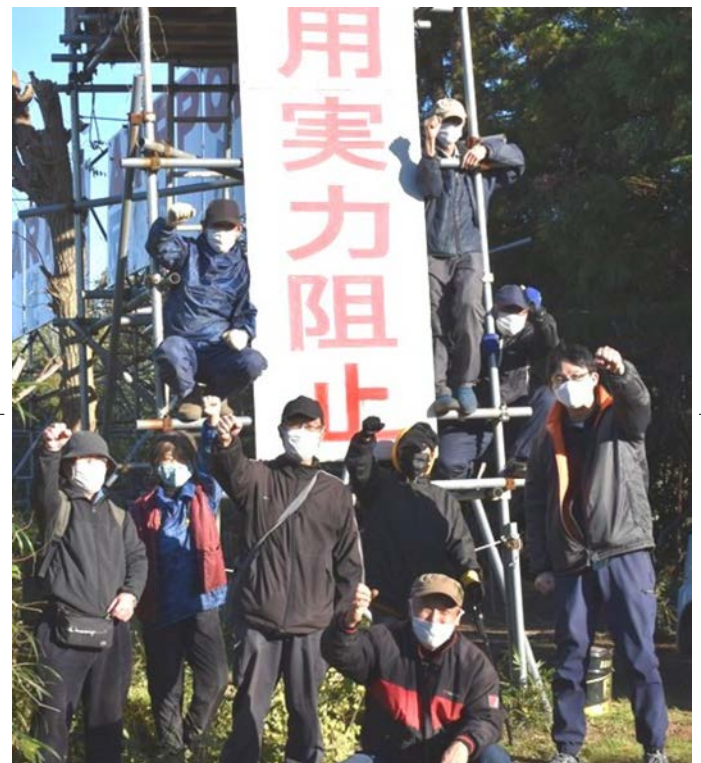
天神峰カフェで大看板の修繕作業 (21年11月27日)
