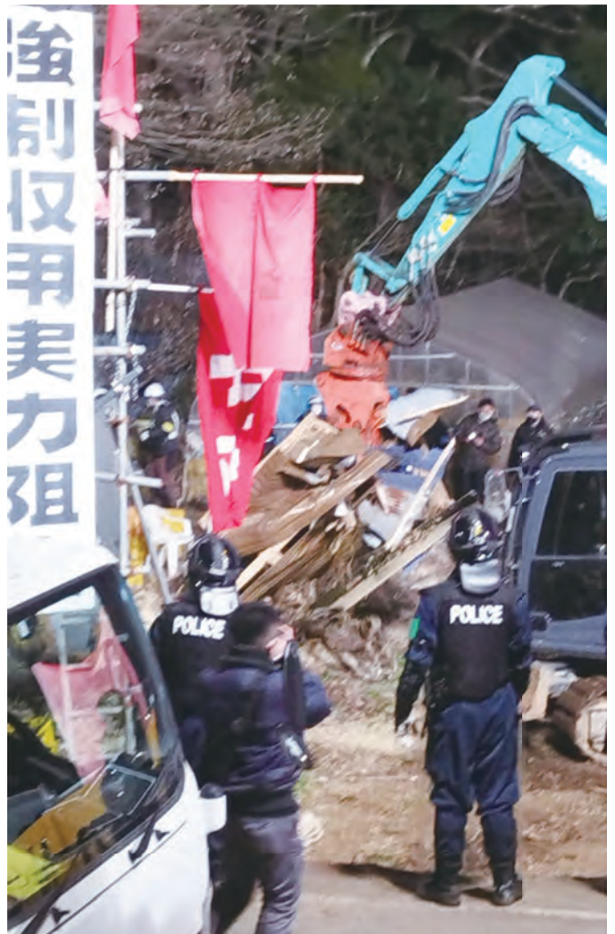
機動隊に守られながら問答無用でトイレを破壊する重機
